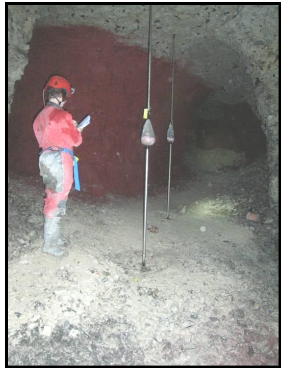
Photographie 7 : Cannes de convergence ST4 CV1 et ST4 CV2 (Photo 164)
