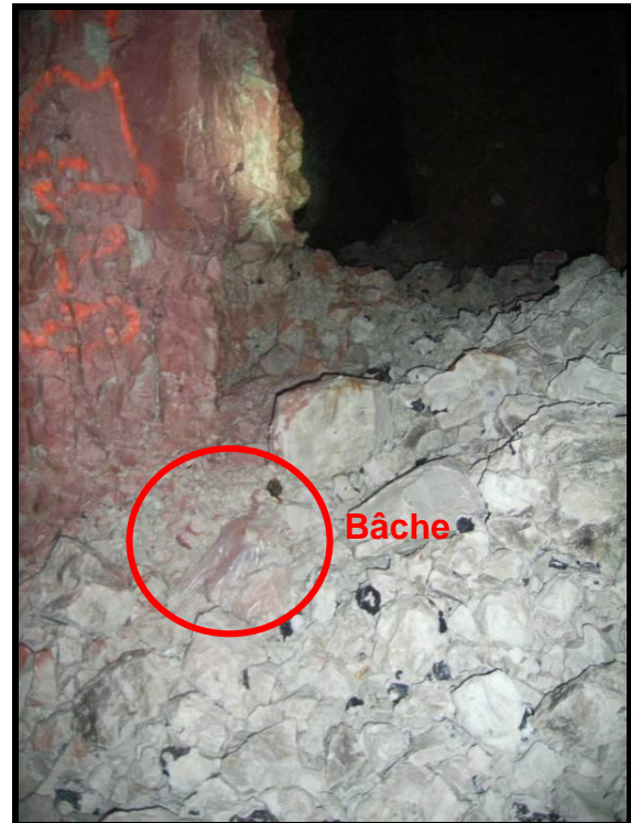
Photographie 9 : Blocs sur bâche sous MV57 (photo 250)
